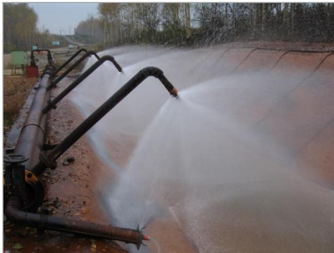
**Figura 22. Sistema de rociado de Haselbach para la desacidificación y aireación de las aguas subterráneas (MIBRAG mbH)**
