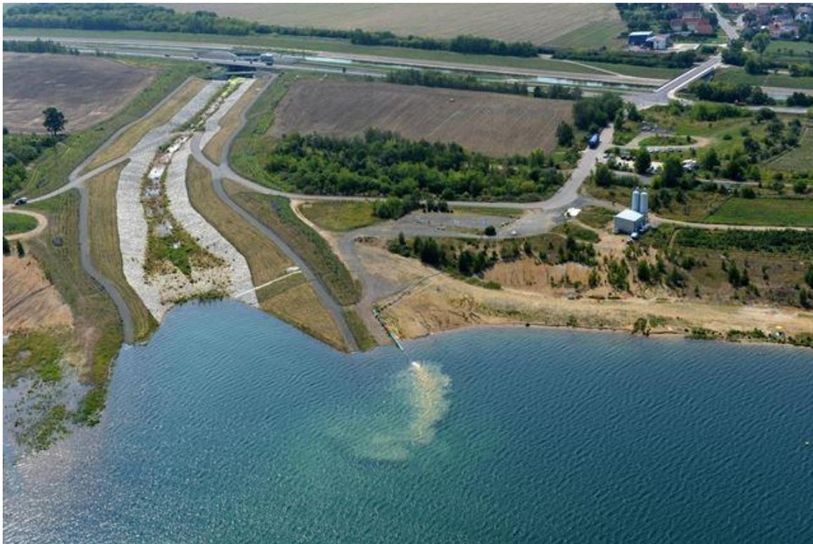
**Figura 14. Lago Zwenkau: Desagüe de agua de crecida de Zitschen con canal de llenado y planta de neutralización (LMBV mbH)**
